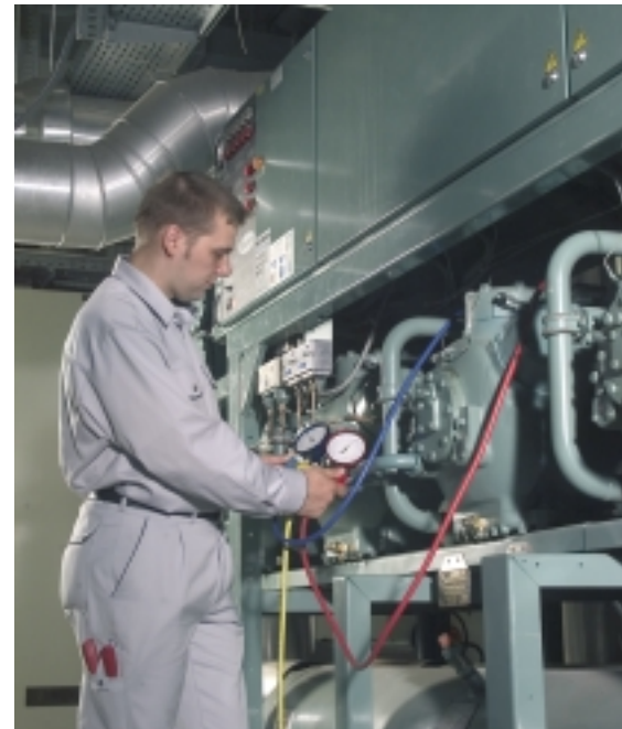
Pharماسerv-Mitarbeiter bei Wartungsarbeiten in der Energiezentrale
