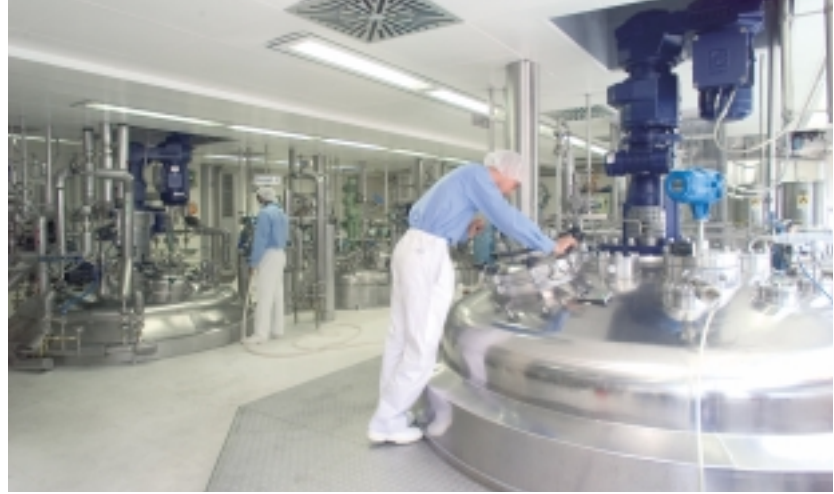
Pharmaserv-Mitarbeiter bei Wartungsarbeiten in der Energiezentrale
