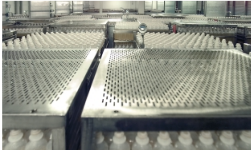
Produktionsanlage Haemacel: Hier erfolgt die Herstellung der Infusionslösung unter Reinraumbedingungen der Klasse "D"
